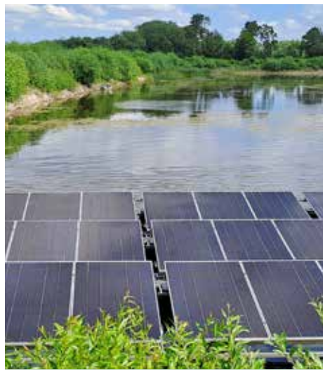
Ett intressant exempel med solceller på bevattningsdamm.
